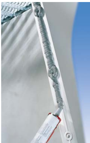
Nakładanie ACO Profix – masy uszczelniającej do doświetlacza okiennych
