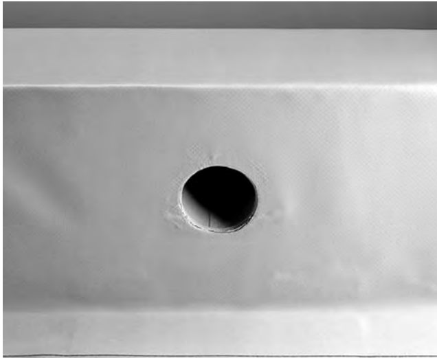
Widok na wykończony szczegół obróbki upustu ściennego prefabrykowanego (S-Drain).
