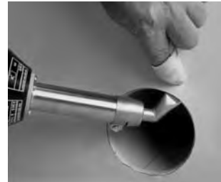
Wytnij fartuch z membrany niezbrojonej z otworem dostosowanym do średnicy wpustu ściennego i przygrzej go do płaszczyzny pionowej wpustu.
