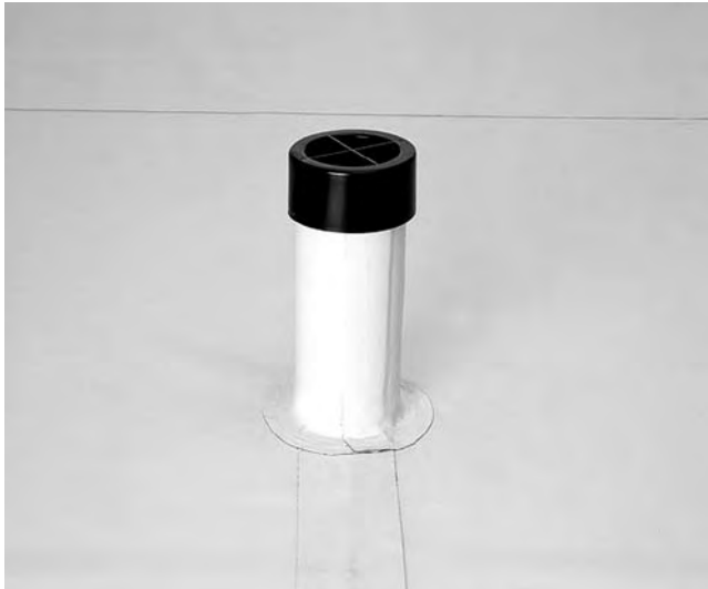
Widok na wykończoną obróbkę wywiewki dachowej.
