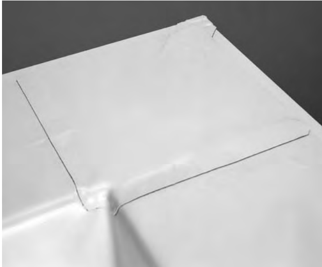
Widok na wykończony narożnik wewnętrzny ściany attyki.
