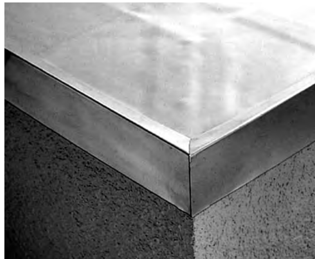
Widok na wykończony narożnik zewnętrzny budynku od strony elewacji.
