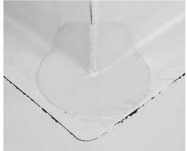
Widok na wykończony narożnik zewnętrzny prefabrykowany S ® -Corner PVC 90° / WA
