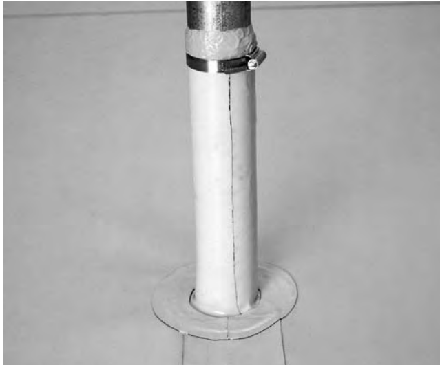
Widok na wykończoną obróbkę słupa z obejmą dociskową i kitem uszczelniającym.
