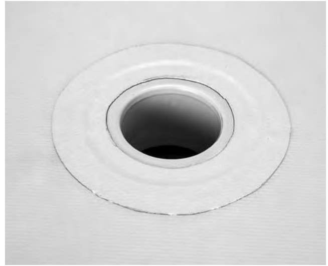
Widok na wykończony wpust dachowy z „twardego” PCW.
