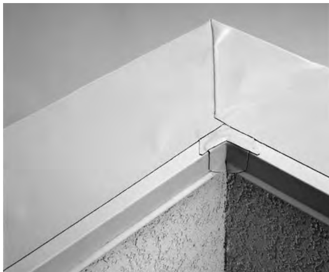
Widok na wykończony narożnik wewnętrzny budynku (od strony elewacji).
