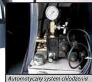
Automatyczny system chłodzenia
