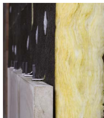
Zdjęcie 3 - Fasada wentylowana z okładziną kamienną
