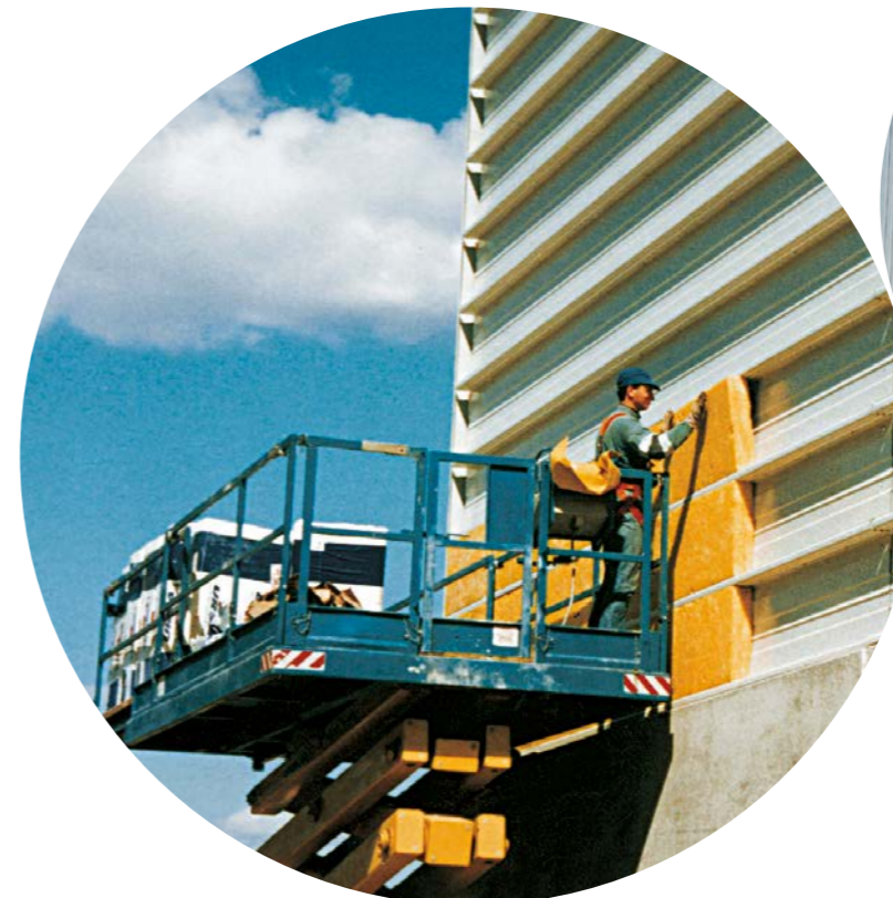
Zdjęcie 6 - Montaż płyt izolacyjnych URSA przy izolacji hal stalowych
