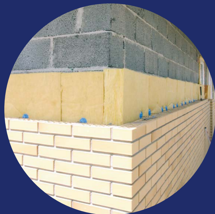
Zdjęcie 4 – Mur trójwarstwowy ze szczeliną wentylacyjną
